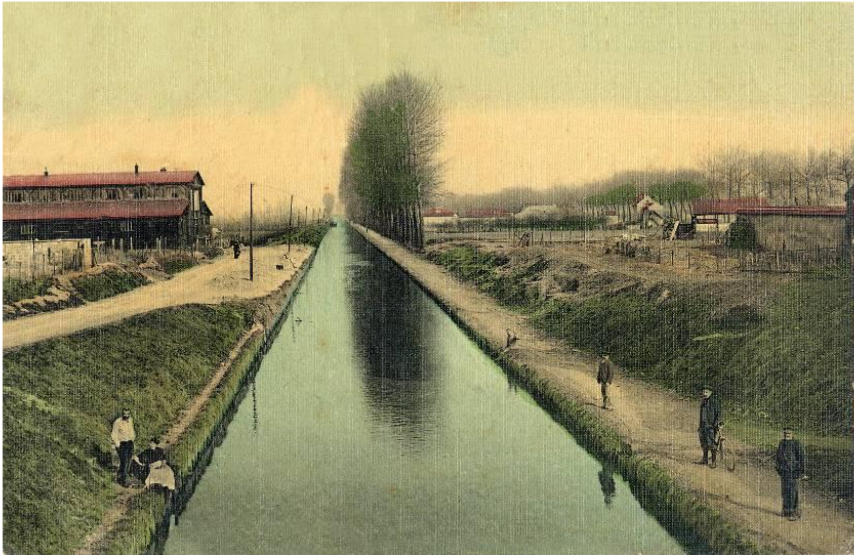
Le canal en direction de Bondy
