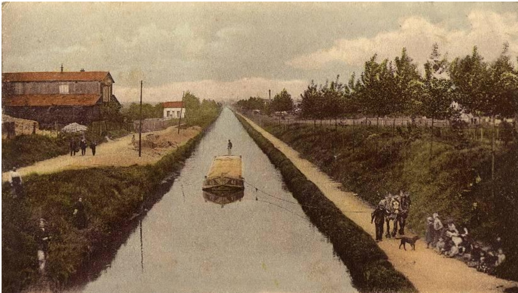
Le canal en direction de Bondy
